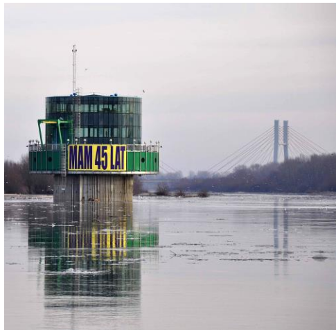
HFB "Gruba Kaśka", Warschau, PL Q = bis 5.000 m 3 /h, Schacht- Ø: 11 m, 15 Stränge, Gesamtlänge 1472 m (Ø = 98 m)
