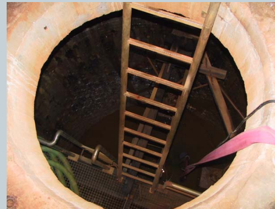
Marienquelle, Quellkeller: Blick in den Quellschacht
