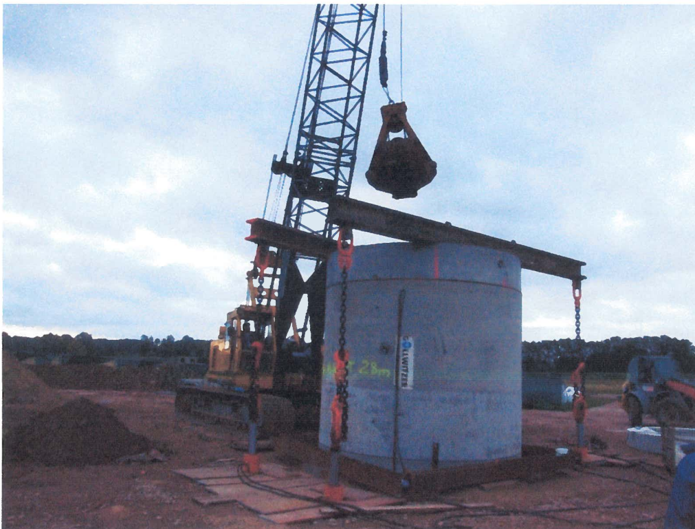
Abteufen der Schächte
