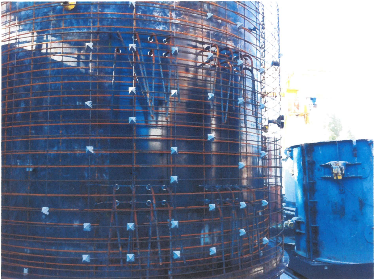
Bewehrungsabnahme im Betonwerk Rückhängebewehrung für die Montagemunfen Pumpenkonsole
