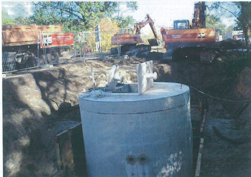
Bau des Ableitungssystems in Hoyerswerda, Schachtbauwerk 11 nach Durchörterung Alte Elster
