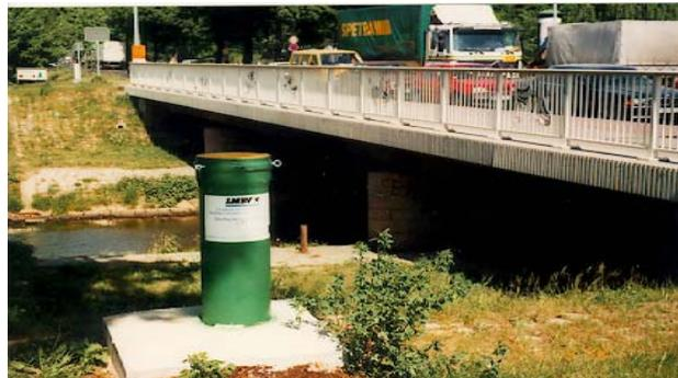
Oberflächenmessstelle mit Drucksonde, Datenlogger, Datenfernübertragung und Lattenpegel
