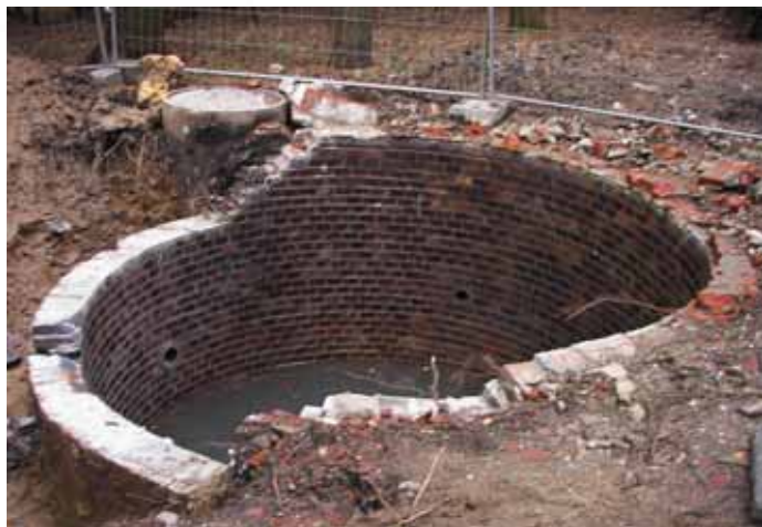
Bahnhausbrunnen nach dem Abbruch des Konus
