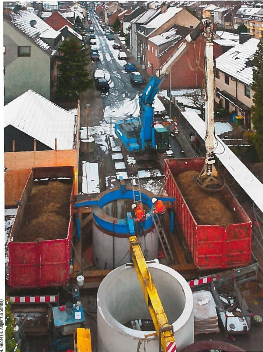
Abb. 1 – Errichtung eines Horizontalfilterbrunnens in Nassaufstellung zur Grundwasserniederhaltung in einer Kleinsiedlung in Oberhausen. Hier erfolgte die Baustelleneinrichtung auf engstem Raum.
