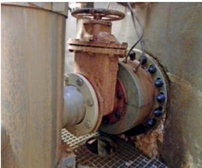
Abb. 7 – Schieberkammer mit drei Piezometerleitungen eines HBr Baujahr 1989
