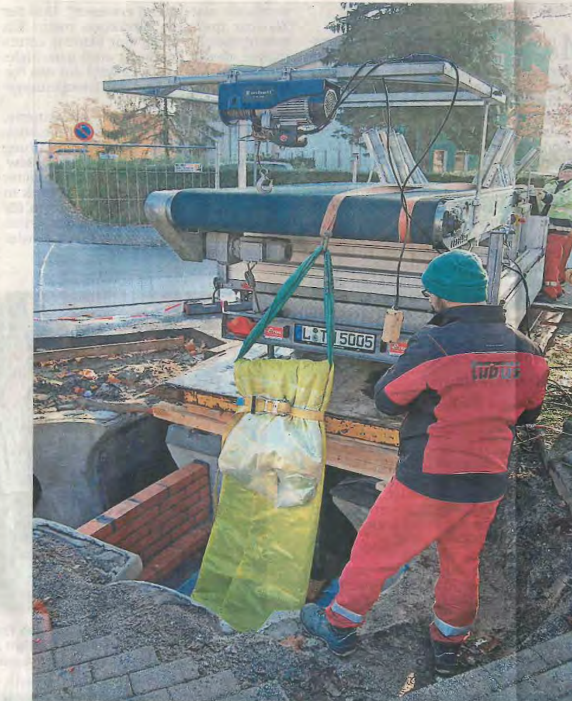
Hier wird bereits das Ende des Linerschlauchs sacht hinabgelassen.
