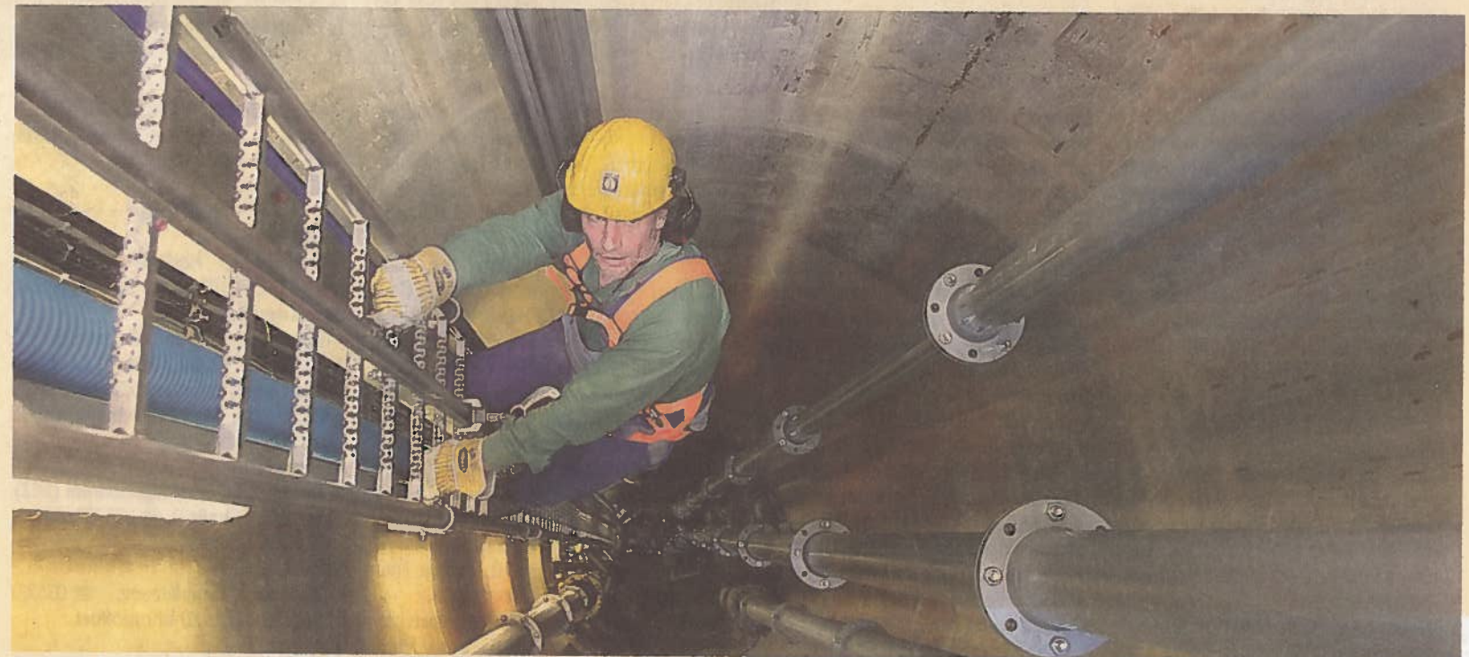
Der Horizontalfilterbrunnen „Harry“ arbeitet seit drei Jahren im Dauerbetrieb, um in Hoyerswerda für ungefährliche Grundwasserstände zu sorgen. Monteur Thomas Maibert steigt für Wartungsarbeiten in den 25 Meter tiefen Schacht. Foto: Steffen Rasche
