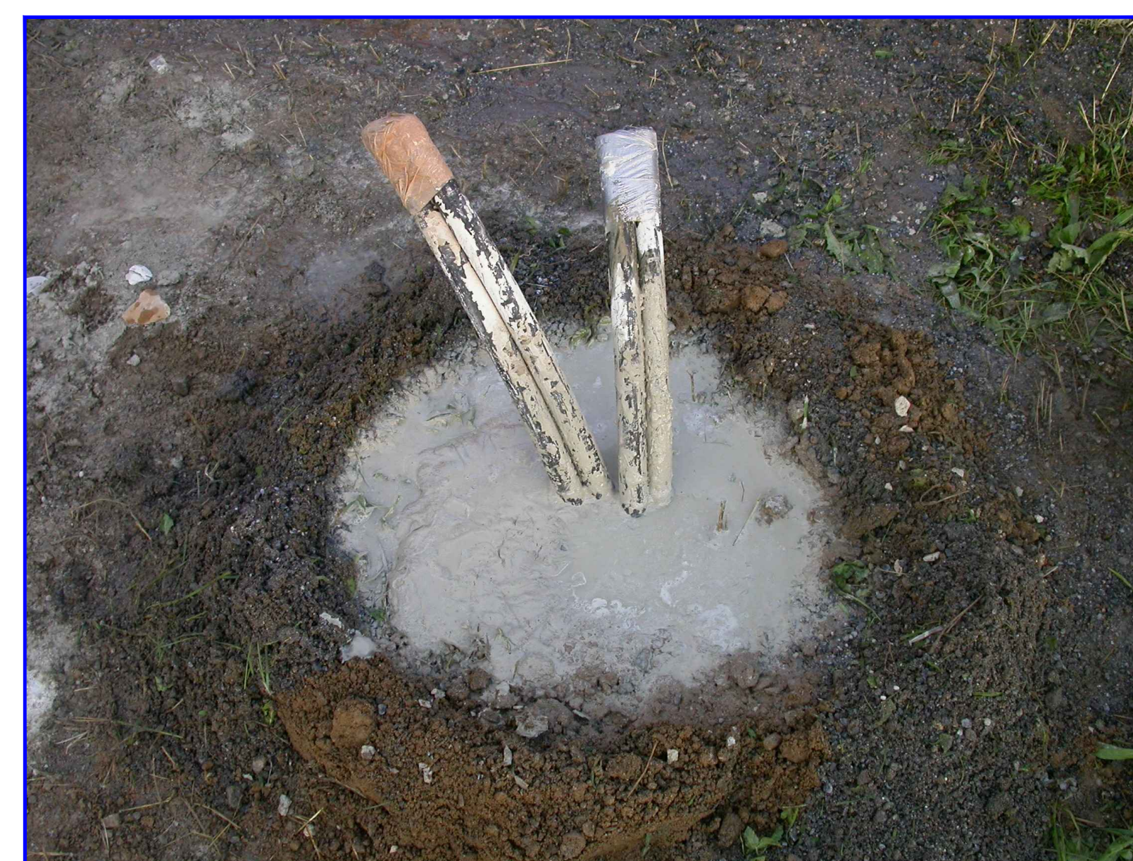
eingebaute Erdwärmesonde
