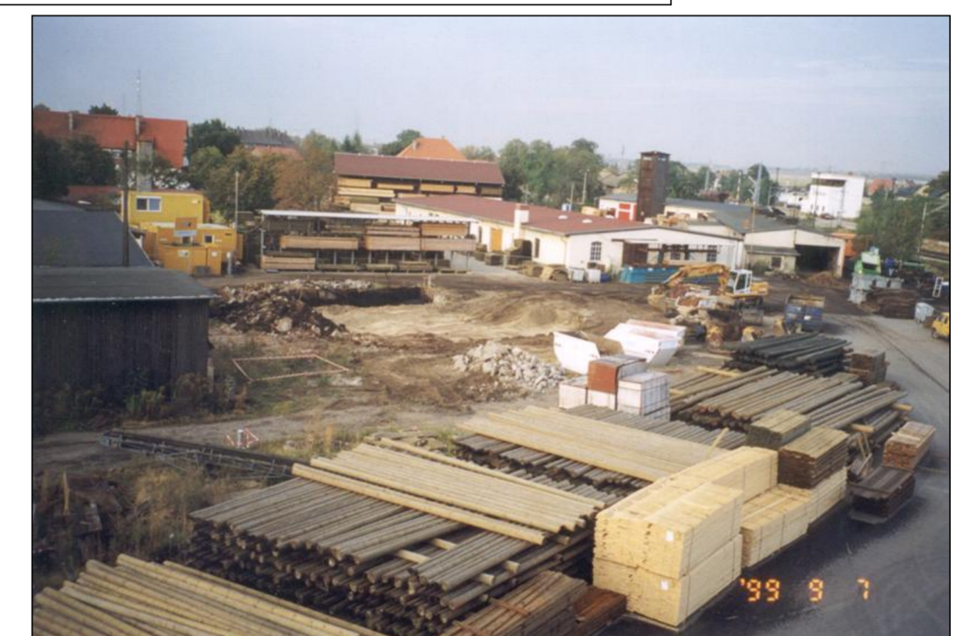
Sanierung bei laufender Produktion
