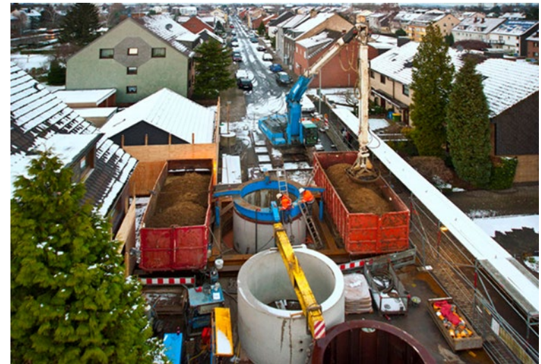
HBr Oberhausen zur Grundwasserniederhaltung
